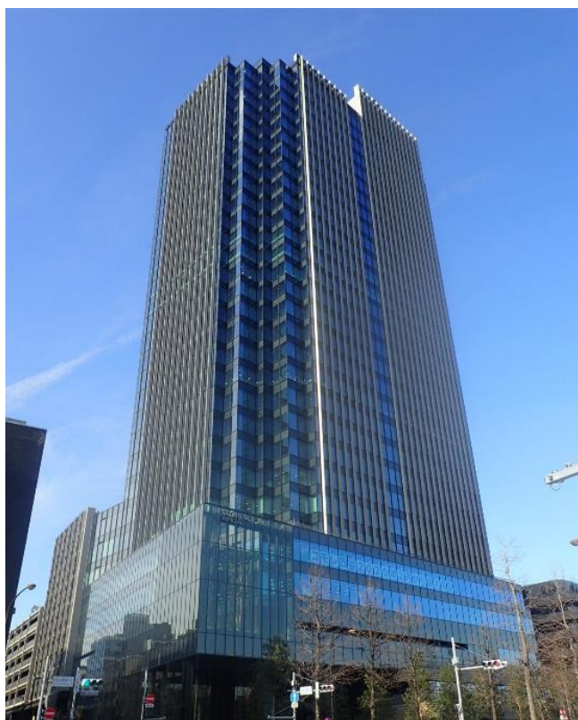
コモレ四谷ビル外観
